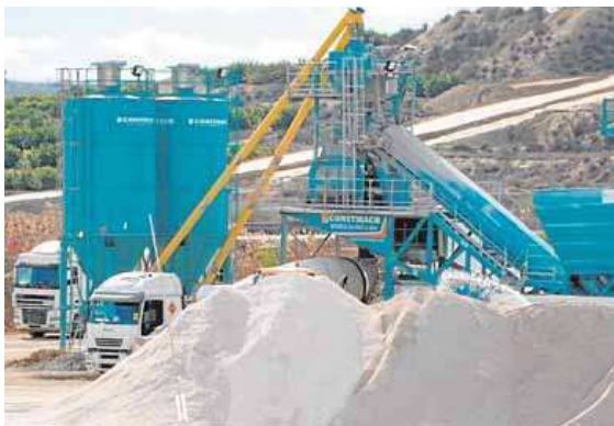
Instalación temporal en Arचना para el Arco Noroeste. JAVIER CARRIÓN / AGM
