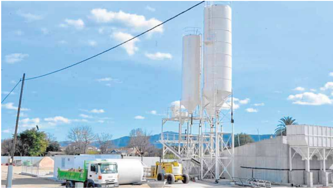
Planta auxiliar de fabricación de hormigón junto a la carretera de Alcantarilla para atender las obras del soterramiento del AVE en Murcia. V. VICÉNS / AGM
