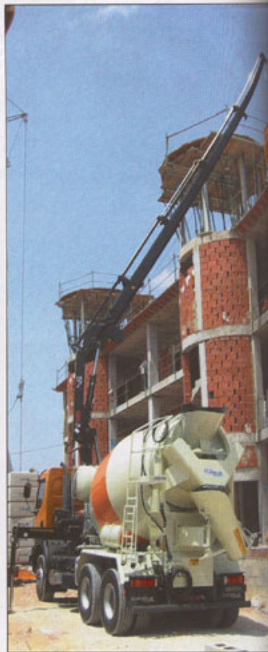
Figura 2. Camión Hormigonera de 6 m 3 con Grúa.
