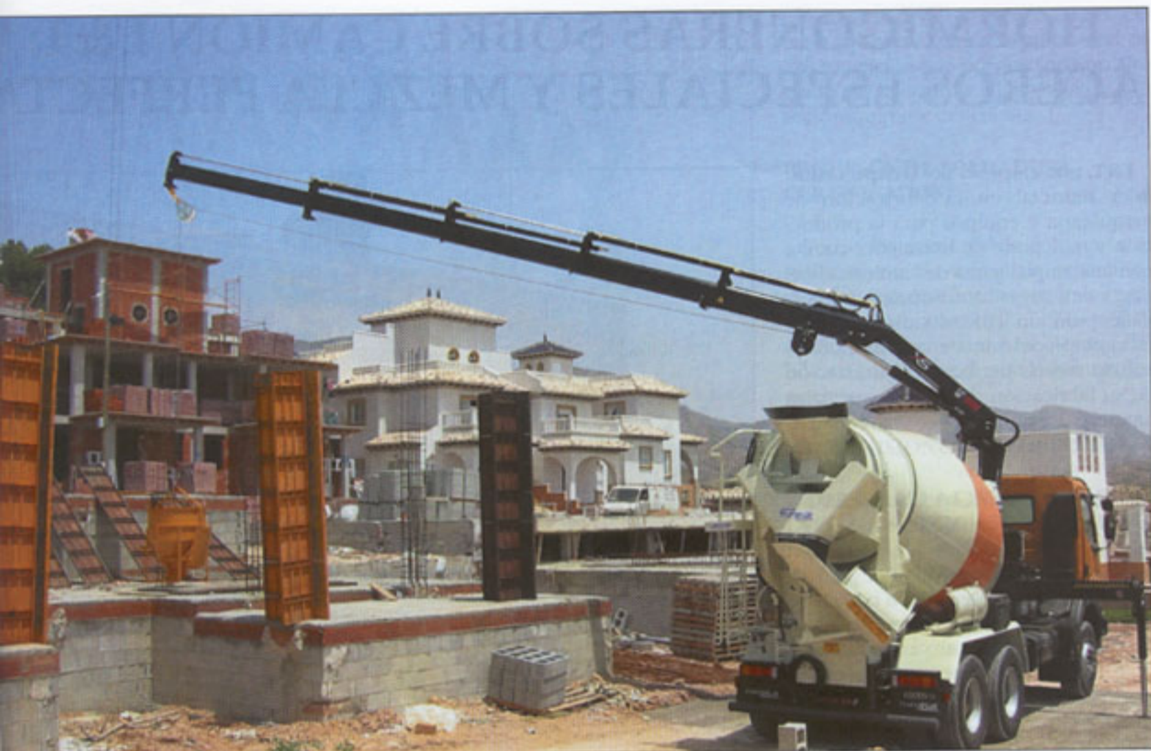
Figura 3. Camión Hormigonera de 6 m 3 con Grúa.
